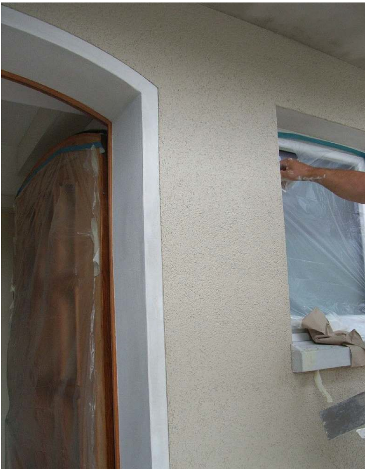
Abbildung 5-13: Edelputz im Leibung- und Sturzbereich.
