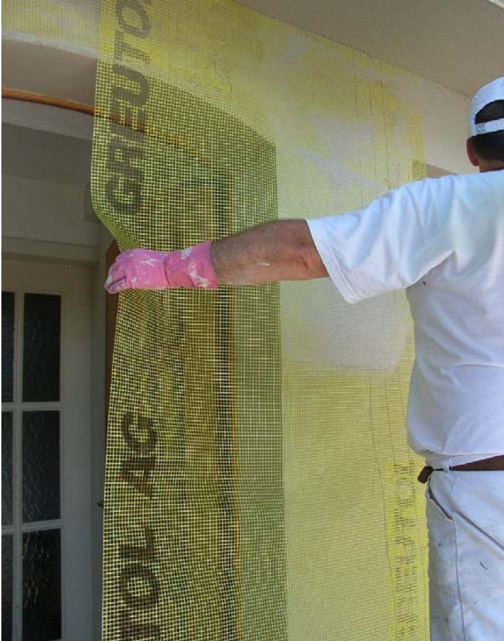
Abbildung 5-12: Gewebearmierung vollflächig im Grundputz eingearbeitet.
