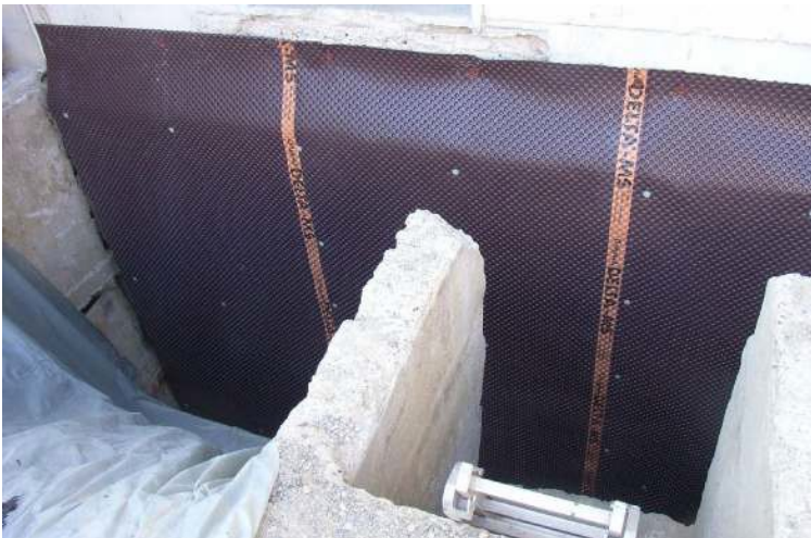
Abbildung 3-27: Noppenfolie als Drainageschicht und Schutz der Perimeterdämmung
