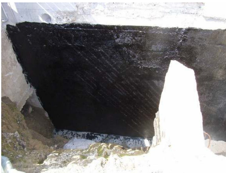
Abbildung 3-21: Wasserschutzanstrich der UG Mauer
