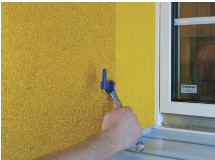
Abbildung 4-44: Befestigung des Klobens vor dem Einhängen der Klappläden.
