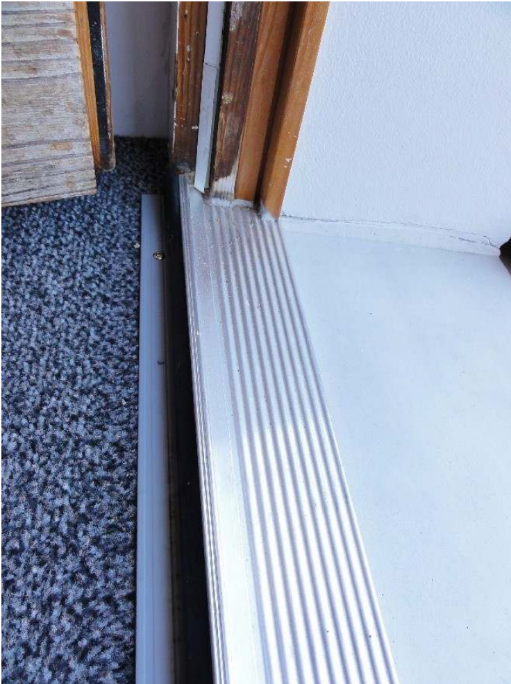
Abbildung 5-8: Schwellenprofil mit Gummidichtung
