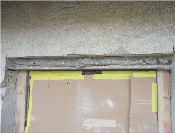
Abbildung 4-31: Sturzarmierung
