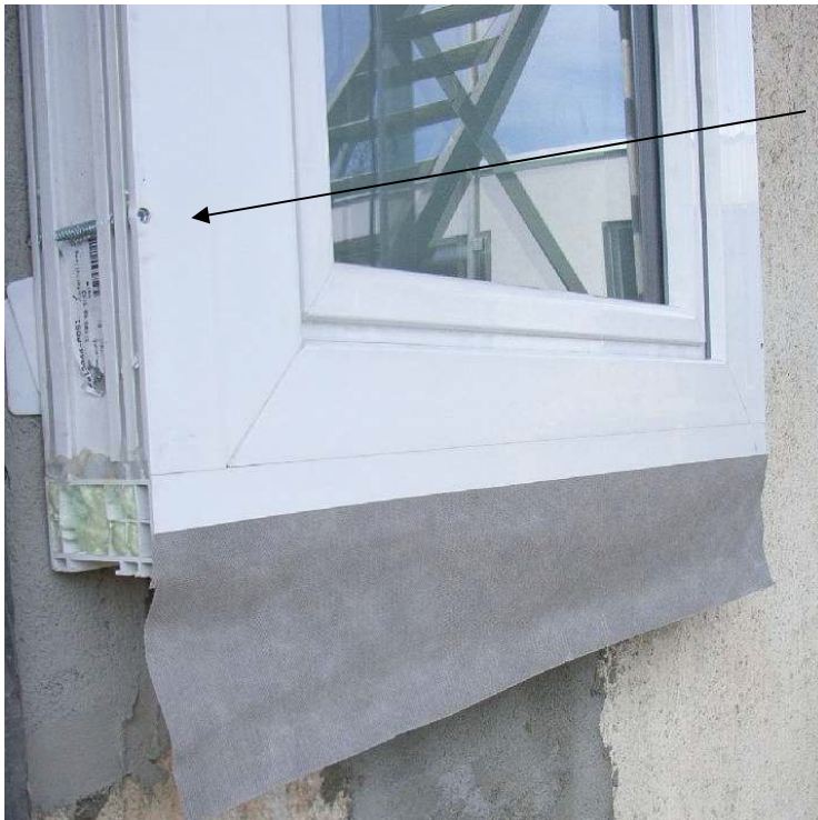
Abbildung 4-35: Fenster angeschlagen
