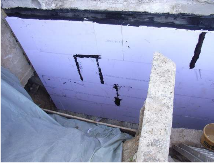
Abbildung 3-26: Perimeterdämmung
