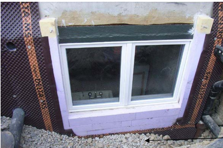
Abbildung 3-32: Kellerfenster vor der Montage des Lichtschachtes
