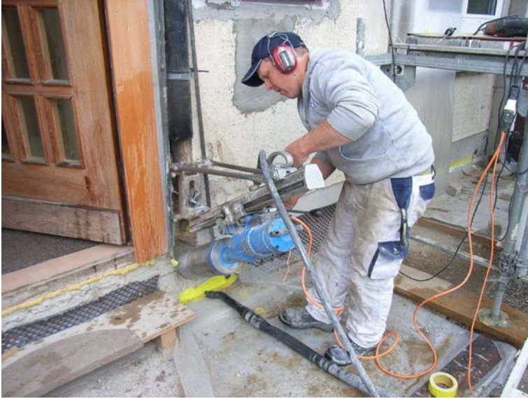
Abbildung 3-12: Kernbohrung im Sockel
