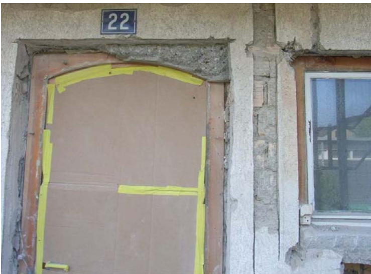
Abbildung 4-32: Erweiterte Mauernischen
