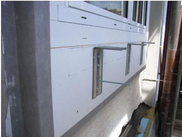
Abbildung 4-36: Montage der Haltewinkel für die Fensterbank
