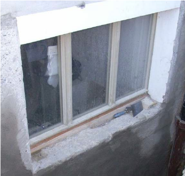
Abbildung 4-20: Das alte Fenster von außen.
