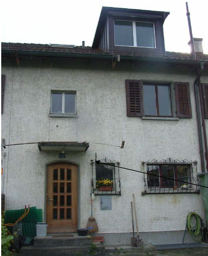
Abbildung 4-14: Fassade vor der Sanierung.
