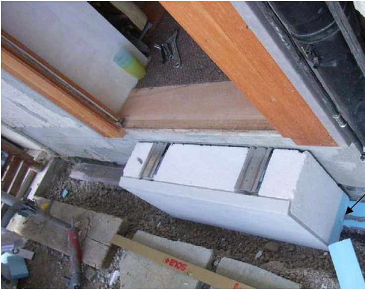
Abbildung 5-6: Sockelelement unter Türschwelle
