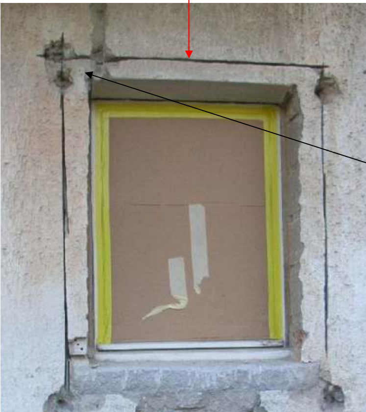
Abbildung 4-30: Der erste Schnitt
