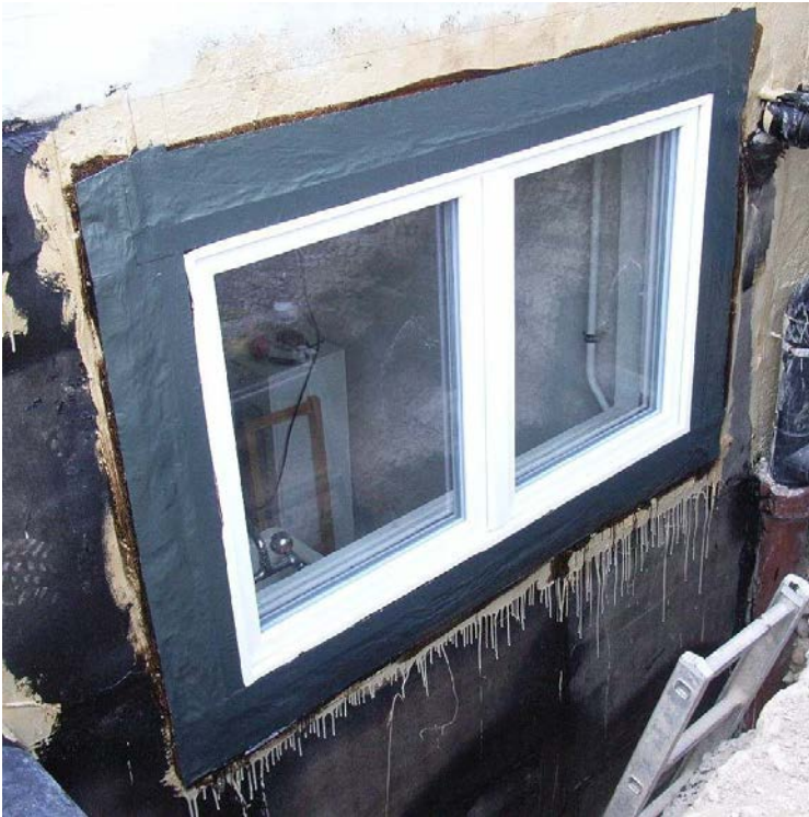
Abbildung 4-22: Das neue Fenster, Ansicht von außen.
