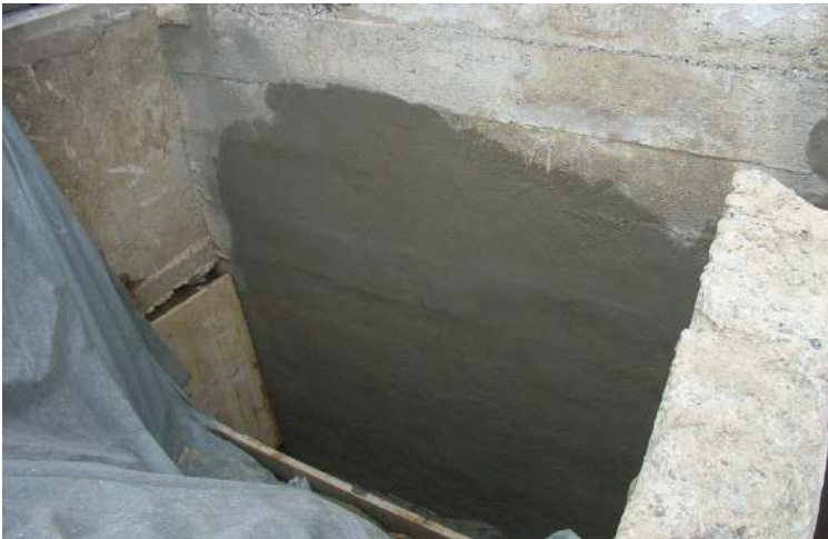
Abbildung 3-19: Verspachtelte, sanierte UG-Außenmauer
