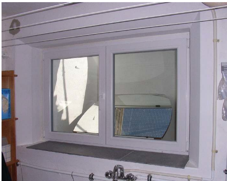
Abbildung 4-25: Das fertige neue Fenster
