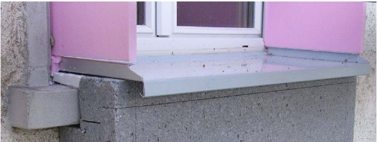
Abbildung 4-10: Wärmebrückenkaschierung bei Sims/Türschwelle
