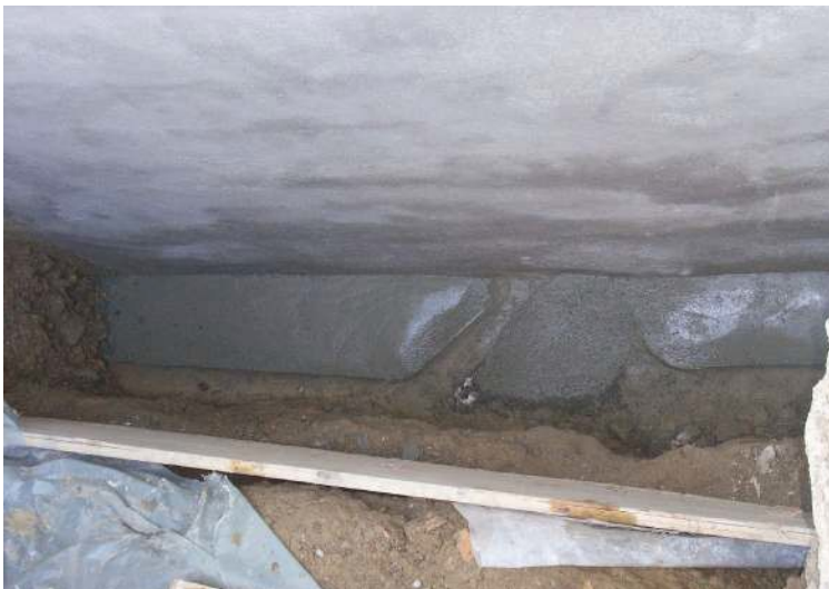
Abbildung 3-20: Einlaufbett für Sickerleitung
