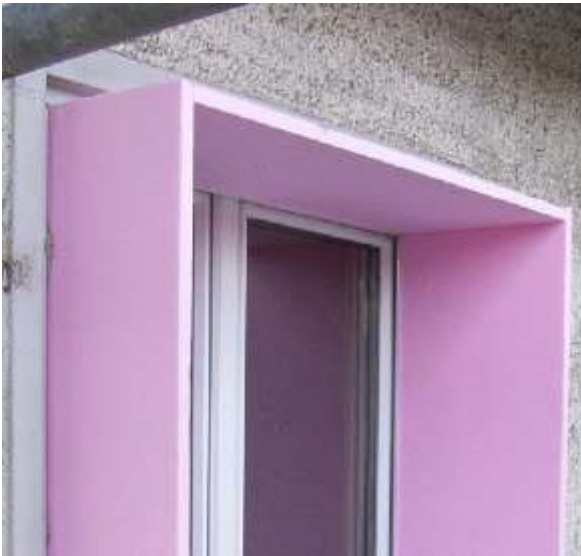
Abbildung 4-8: Leibungs- und Sturzdämmung bzw.: Wärmebrückenkaschierung.
