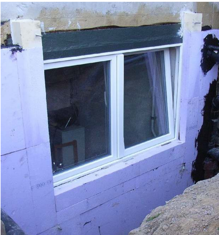
Abbildung 4-23: Überisolieren des neuen Fensterrahmens.
