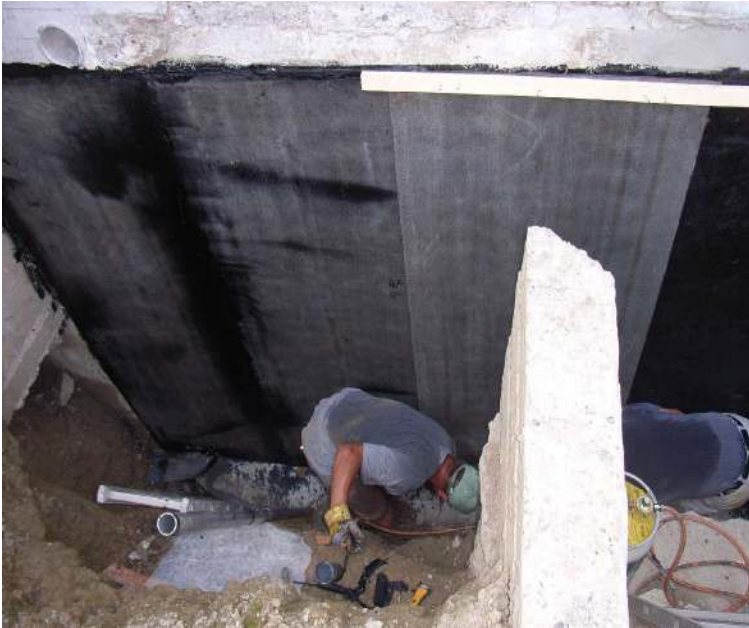
Abbildung 3-22: Anbringung einer zusätzlichen wasserdichten Schutzschicht auf den UG-Außenmauern.
