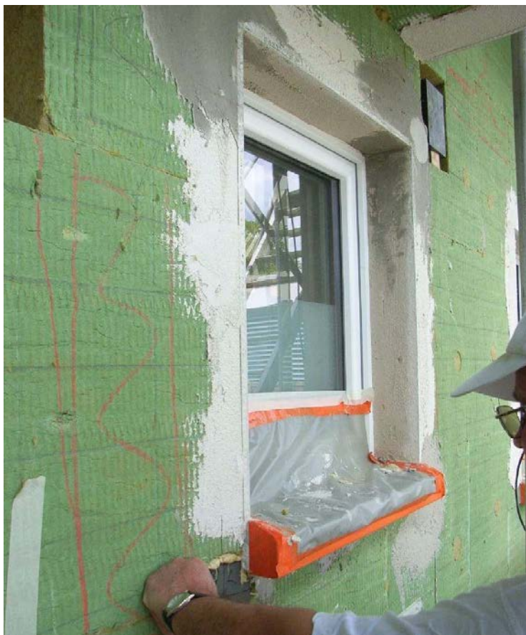
Abbildung 4-39: Fensternische aus Fassadenisolation
