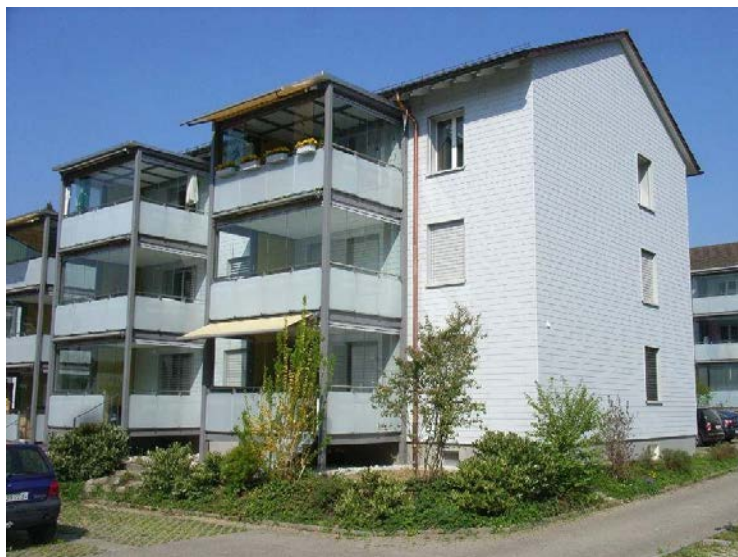
Abbildung 8-4: Große, separat abgestützte Balkone
