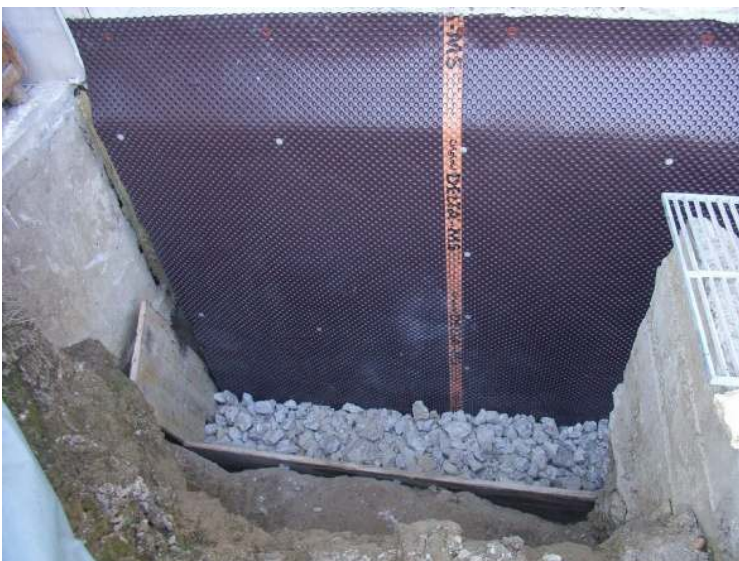
Abbildung 3-28: Auffüllen mit Betonbruch als Sickerschicht
