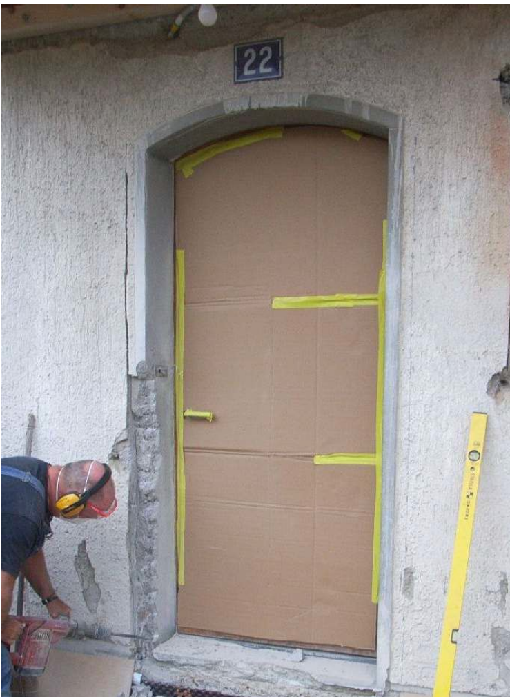
Abbildung 5-2: Schneiden und entfernen des alten Gewändes und der Türschwelle.
