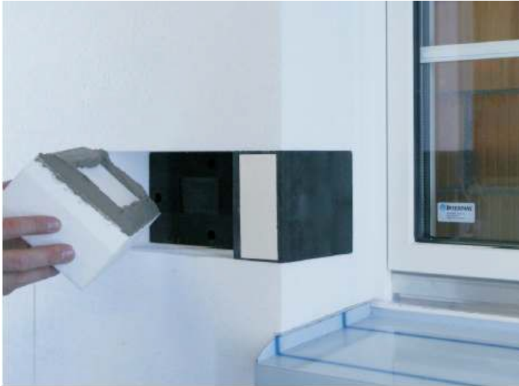
Abbildung 4-43: Schließen der Isolation nach der Montage des Klobenelementes
