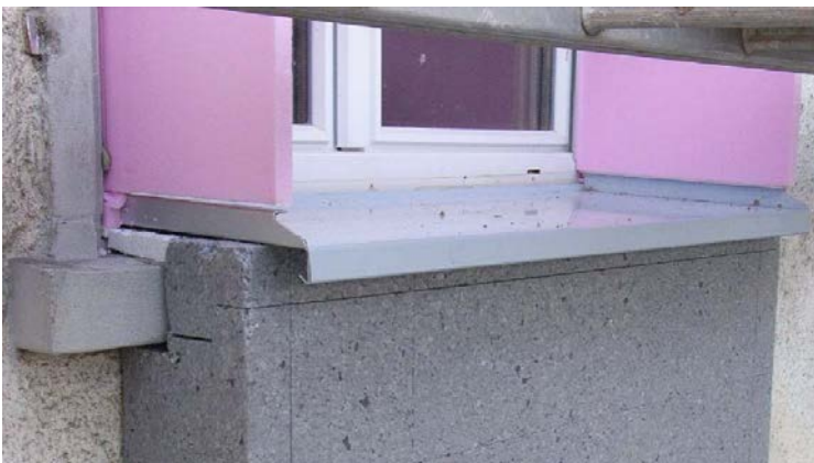
Abbildung 4-41: Fensterbankersatz durch Blech
