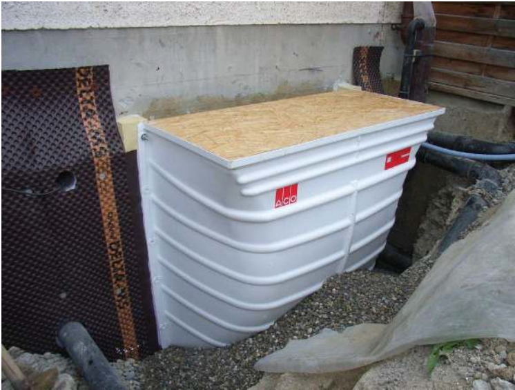
Abbildung 3-33: Kunststofflichtschacht montiert
