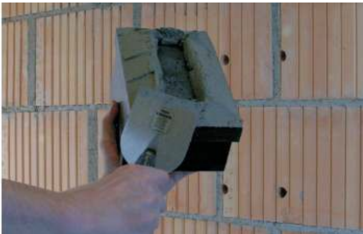
Abbildung 4-53: Klebemörtelbett für Schwerlastelement
