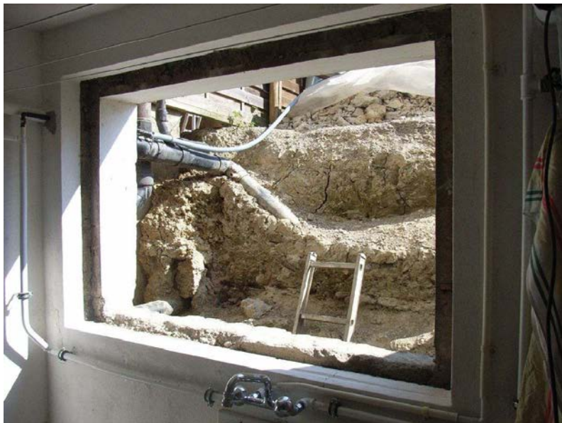
Abbildung 4-21: Altes Fenster demontiert, Ansicht von innen.
