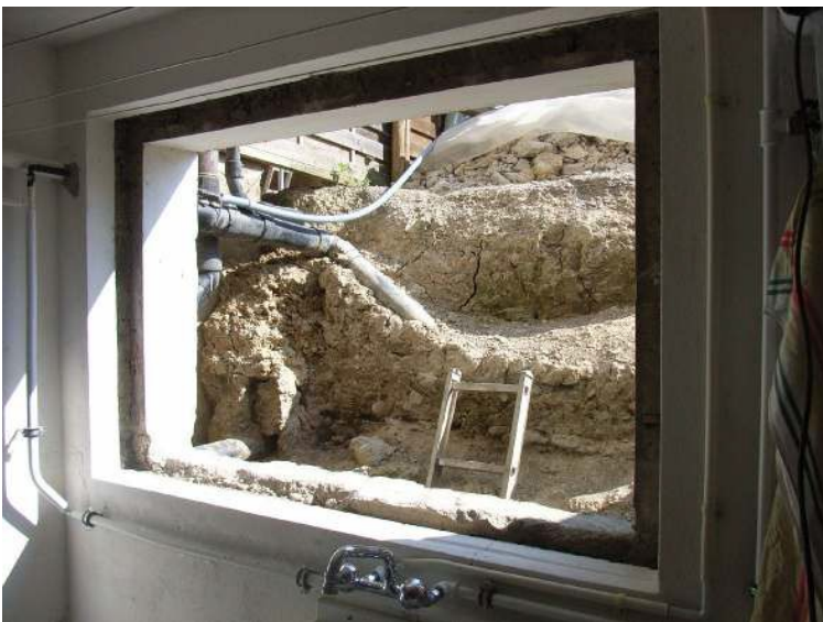
Abbildung 3-24: Blick in die "lehmige" Baugrube durch das bereits entfernte Kellerfenster (Waschküche).
