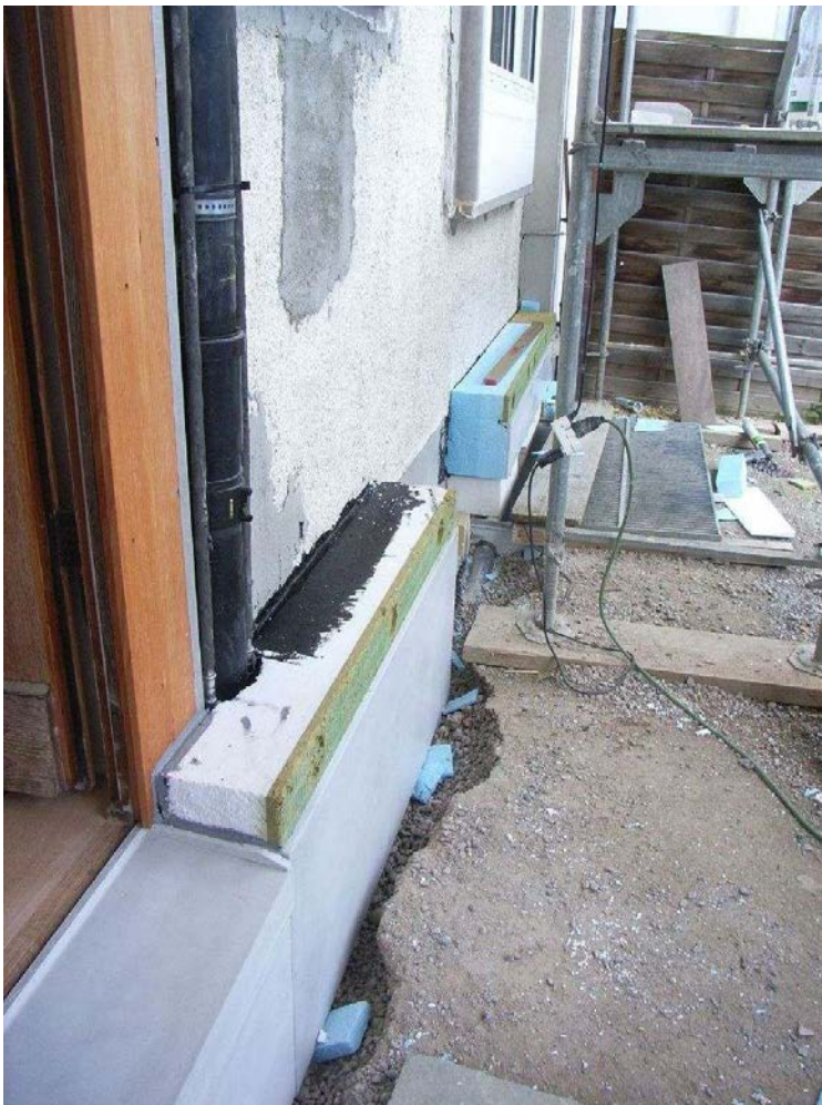
Abbildung 5-7: Türschwelle und anschließende Sockelelemente
