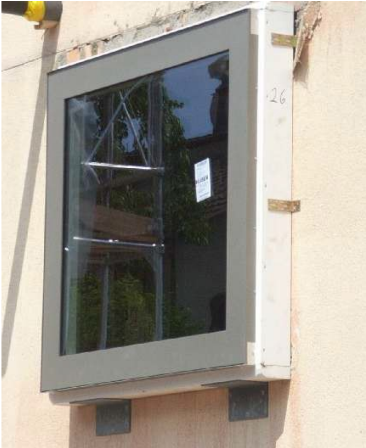
Abbildung 4-34: Fensteranschlag
