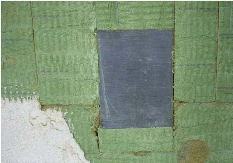
Abbildung 4-55: Fertig "eingepacktes" Schwerlastelement, bereit für den Verputz
