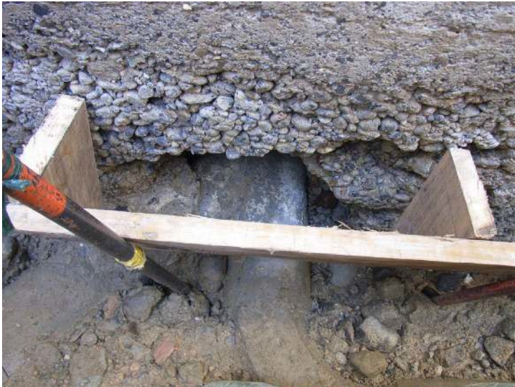
Abbildung 3-16: Offener Rohrdurchbruch in der Außenwand.
