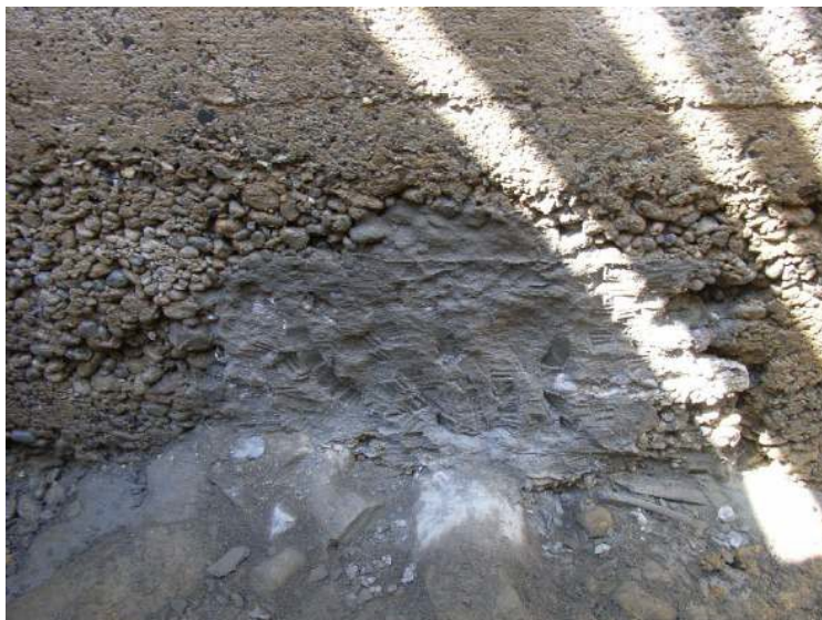
Abbildung 3-17: Abspitzen des "Einlauftrichters"
