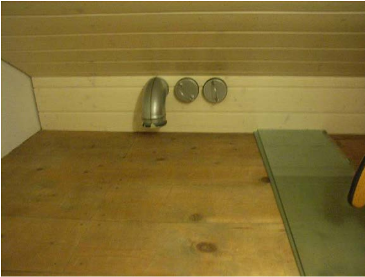
Abbildung 6-7: Einführung der Lüftungsleitungen in den Dachboden, Blick von innen.
