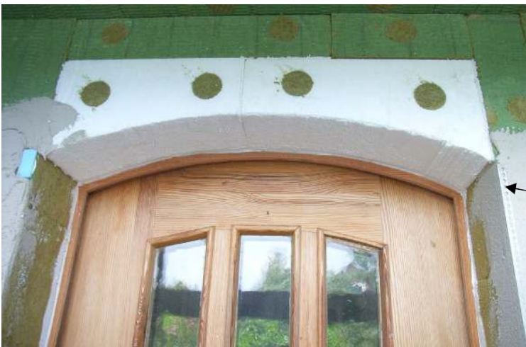
Abbildung 5-9: Runde Sturznachbildung aus Polystyrol
