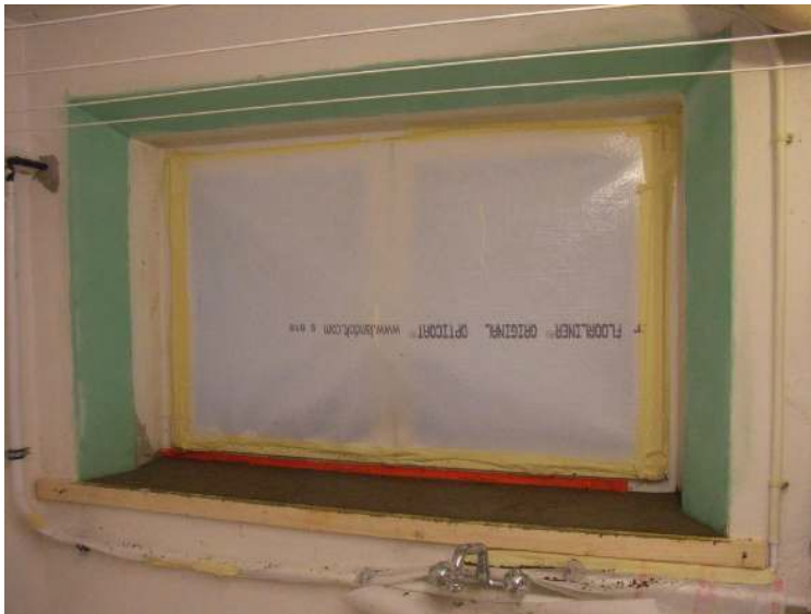
Abbildung 4-24: Neue Fensternische im Rohbau
