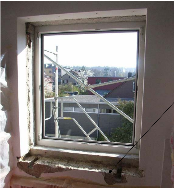
Abbildung 4-15: Fensternische 1 im "Rohbau"
