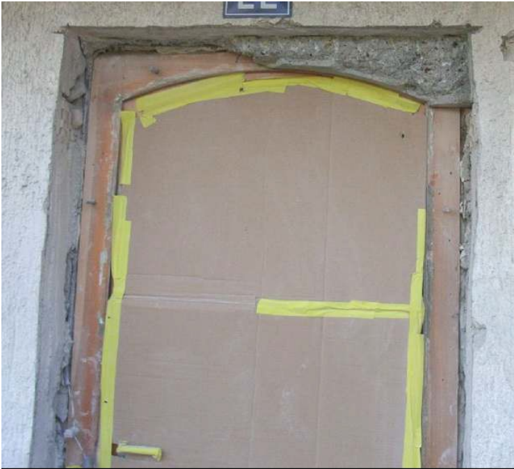
Abbildung 5-3: Der alte Türrahmen wird komplett freigelegt
