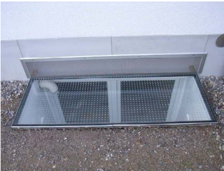
Abbildung 3-34: Lichtschacht fertig
