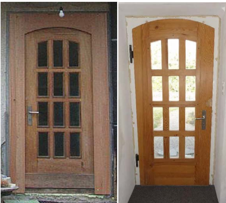
Abbildung 5-4: Neuer Türrahmen, außen angeschlagen (links)
