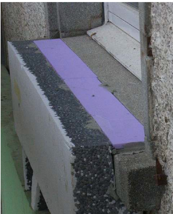
Abbildung 4-10: Wärmebrückenkaschierung bei Sims/Türschwelle
