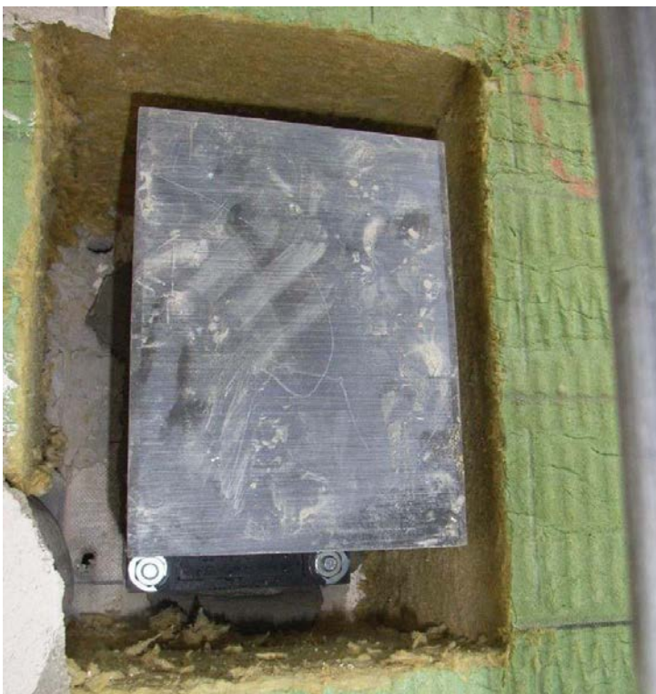
Abbildung 4-54: Schwerlastelement montiert.
