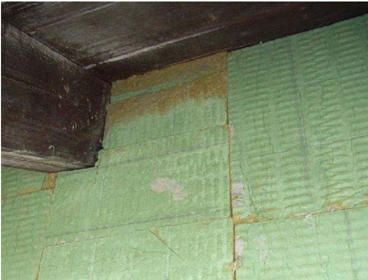
Abbildung 7-5: Fertig Wärmegegedämmter Dachrandanschluss
