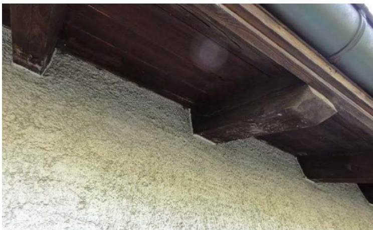
Abbildung 7-2: Ansicht der alten Dachuntersicht.
