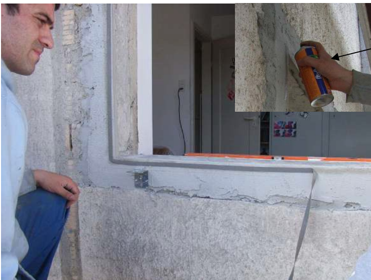
Abbildung 4-33: Anschlagputz und Dichtungsband
