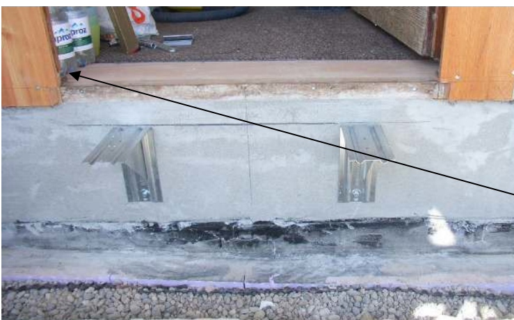
Abbildung 5-5: Haltewinkel für die neue Türschwelle:
