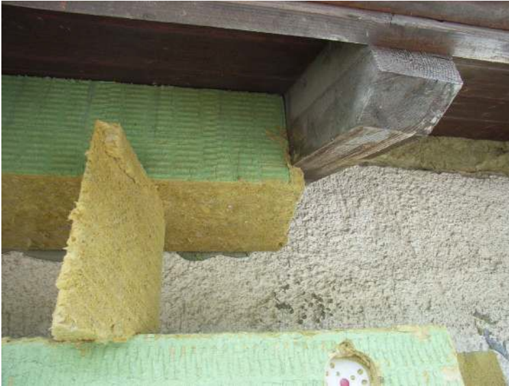
Abbildung 7-4: Wärmedämmung des Dachrandes
