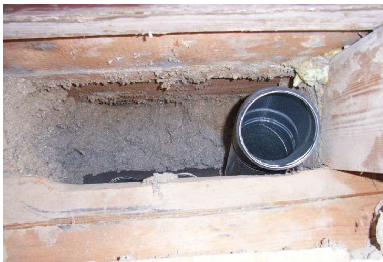
Abbildung 6-6: Einführung der Lüftungsleitungen in den Dachboden.
