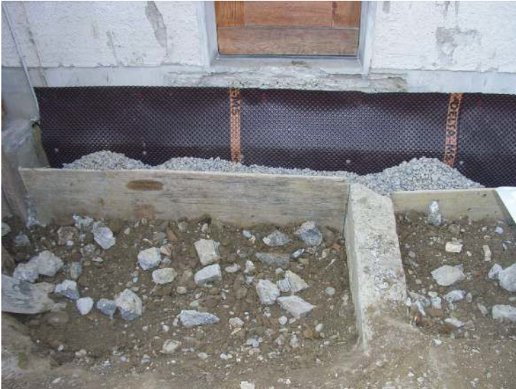
Abbildung 3-29: Auffüllen mit Geröll und Wandkies
