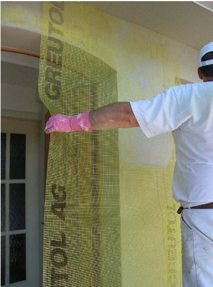
Abbildung 2-3: Armierungsgewebe wird in den Grundputz eingearbeitet.
