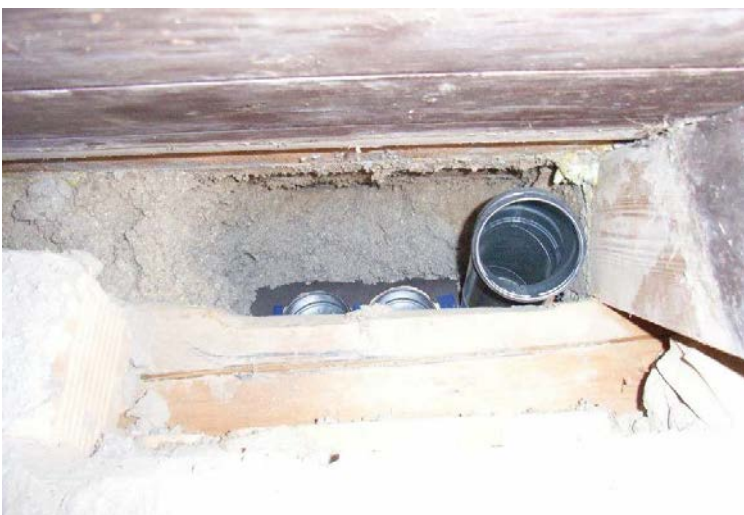
Abbildung 7-3: Dachrand nach Entfernung der Mauerausfachung.
