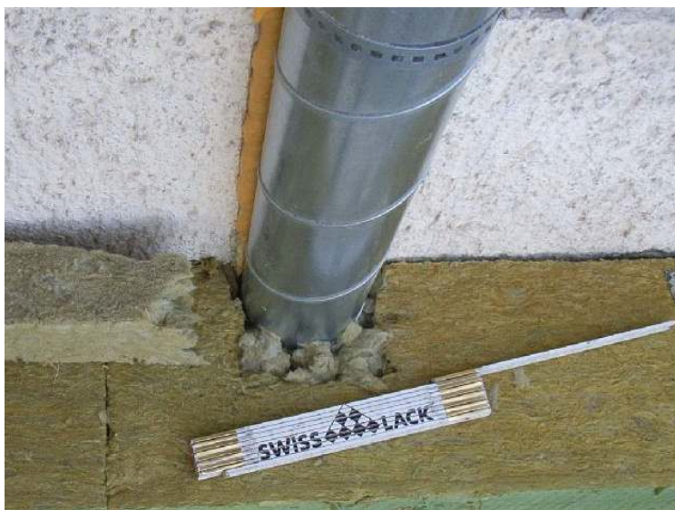
Abbildung 6-5: Dämmung der Lüftungsleitungen (2)
