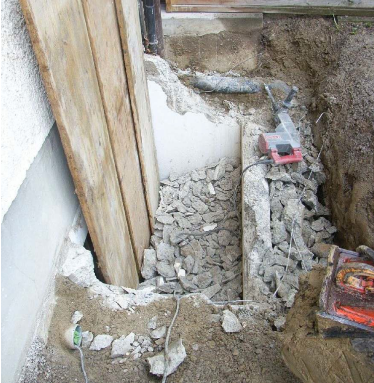
Abbildung 3-14: Abspitzen eines alten Lichtschachtes.
