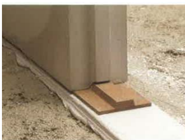
Gipswandbauplatte auf Presskorkstreifen und Stuckgips als Ausgleichsbett auf Betonboden.
