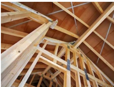
Riegelbau-Konstruktionsprinzip
