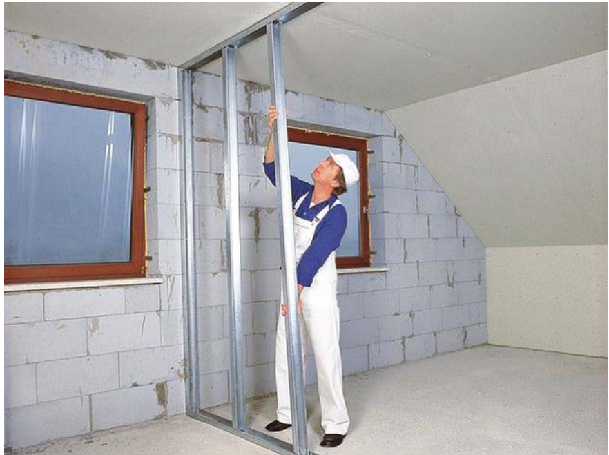
Kaltverformte Stahlblechprofile mit U-förmigem Querschnitt nach EN 14195, vornehmlich zur Anwendung als Randprofil für Wände und freitragende Decken.
